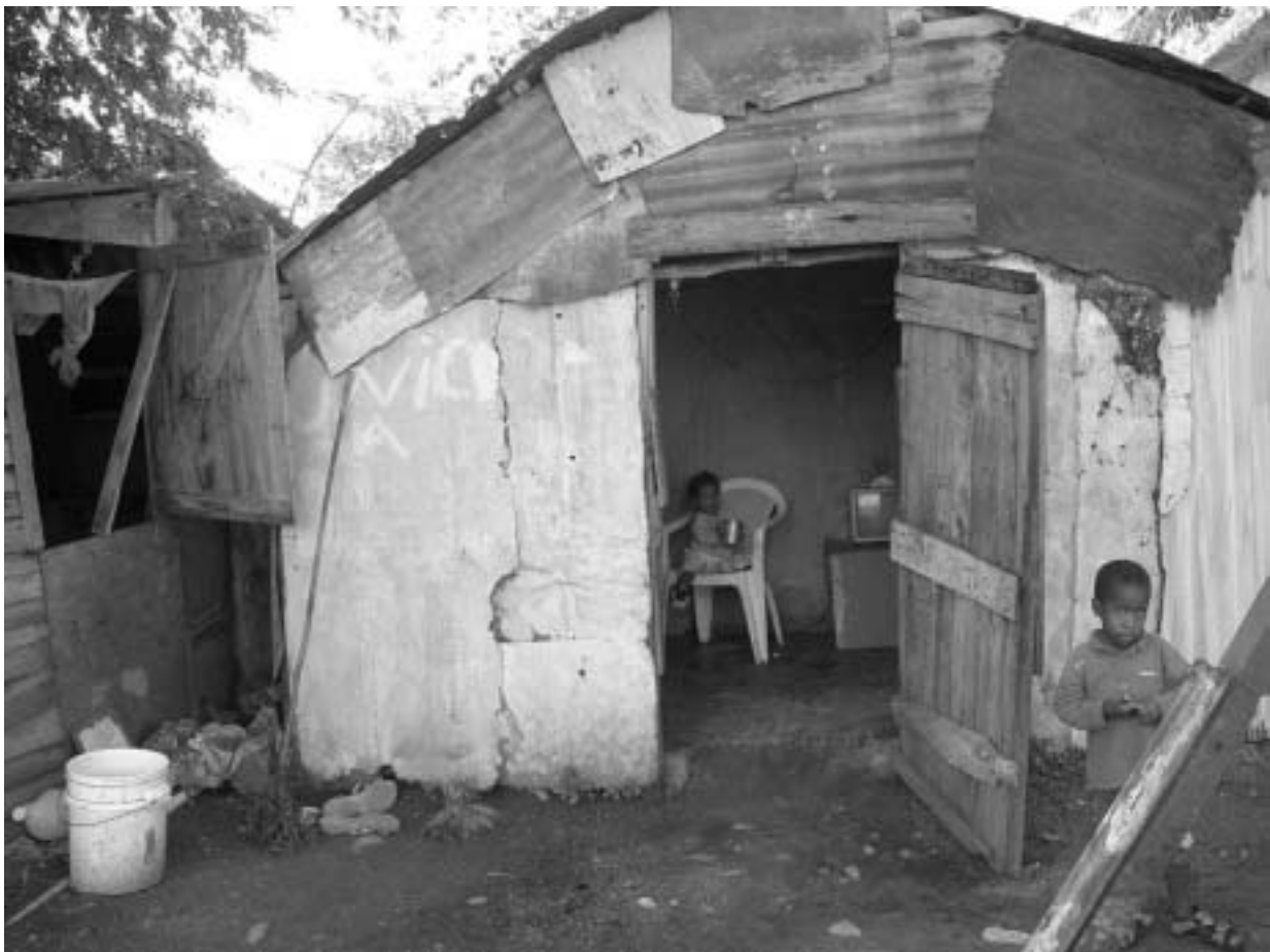
Ein „Haus“ in Nigua. Leider sind dies immer noch übliche Zustände.
